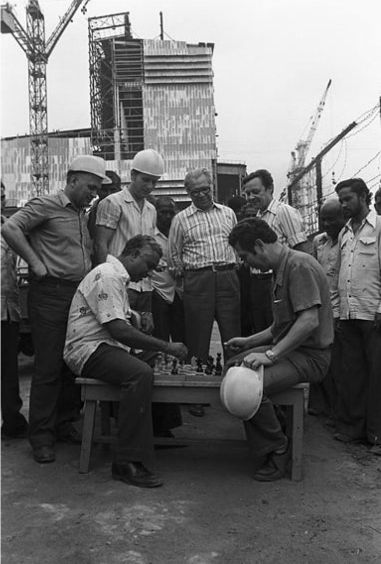
Mittagspause beim Bau einer metallurgischen Werksanlage in Bokaro.
